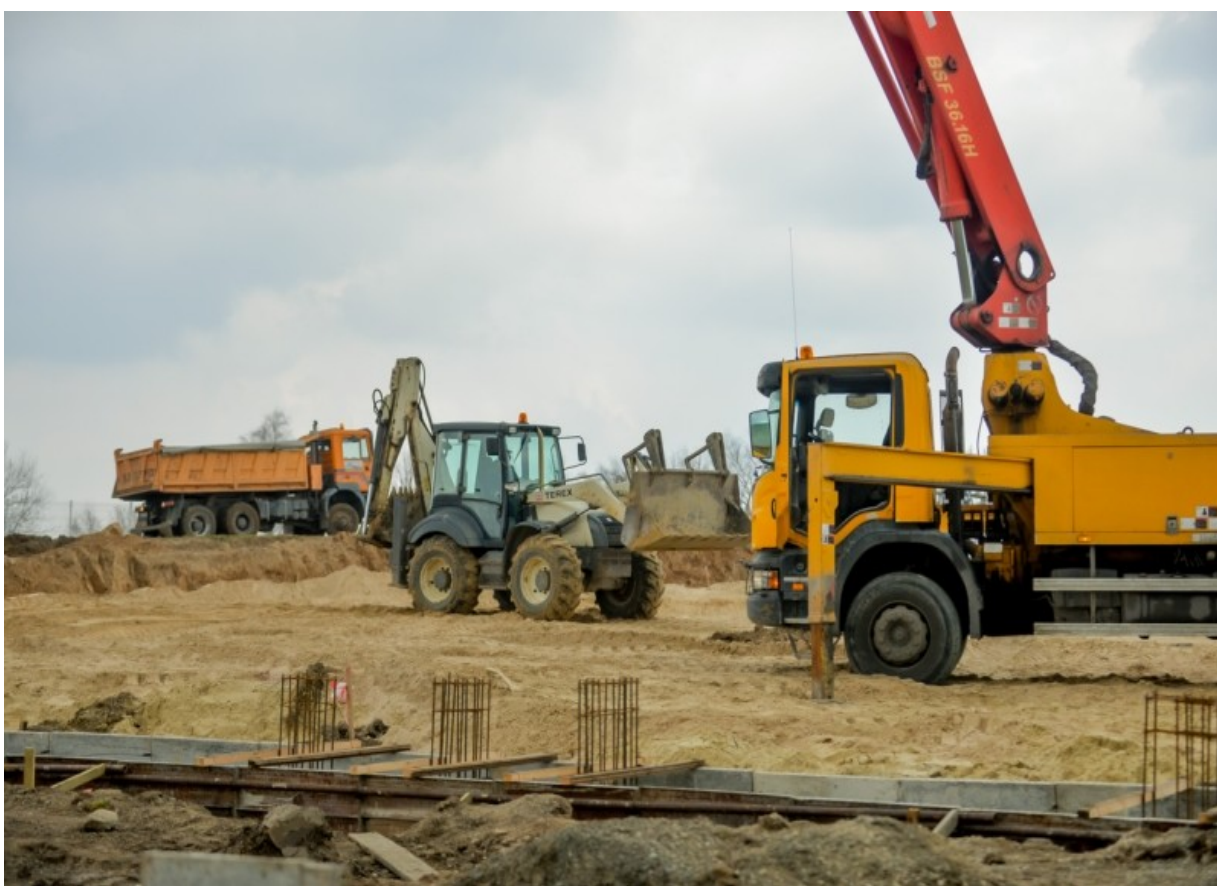
W marcu na plac budowy weszła ekipa budowlana. Rozpoczęto prace ziemne i wylewanie łąw fundamentowych. fot. KAM
